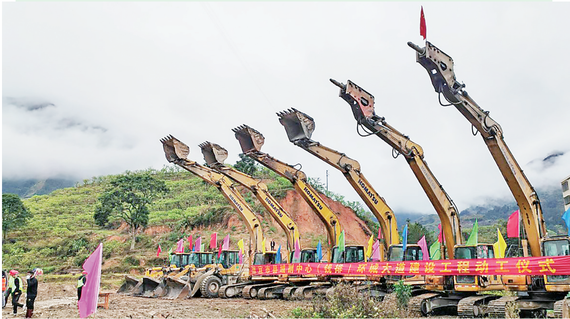
开工建设现场。茂名晚报通讯员 陈子楷 摄
