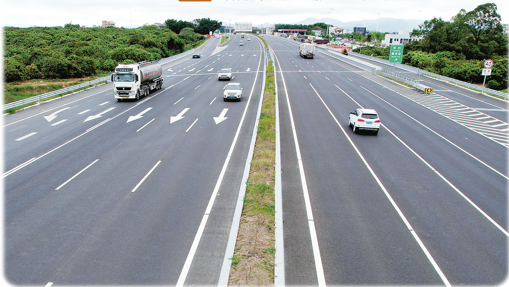
茂湛高速(观珠-茂名互通段)双向八车道路面通行舒适顺畅。
