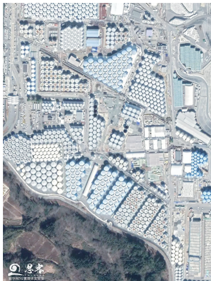
日本福岛第一核电站内的核废水储存罐密密麻麻地摆放着。卫星数据来源:MAXAR (2019年3月拍摄)
