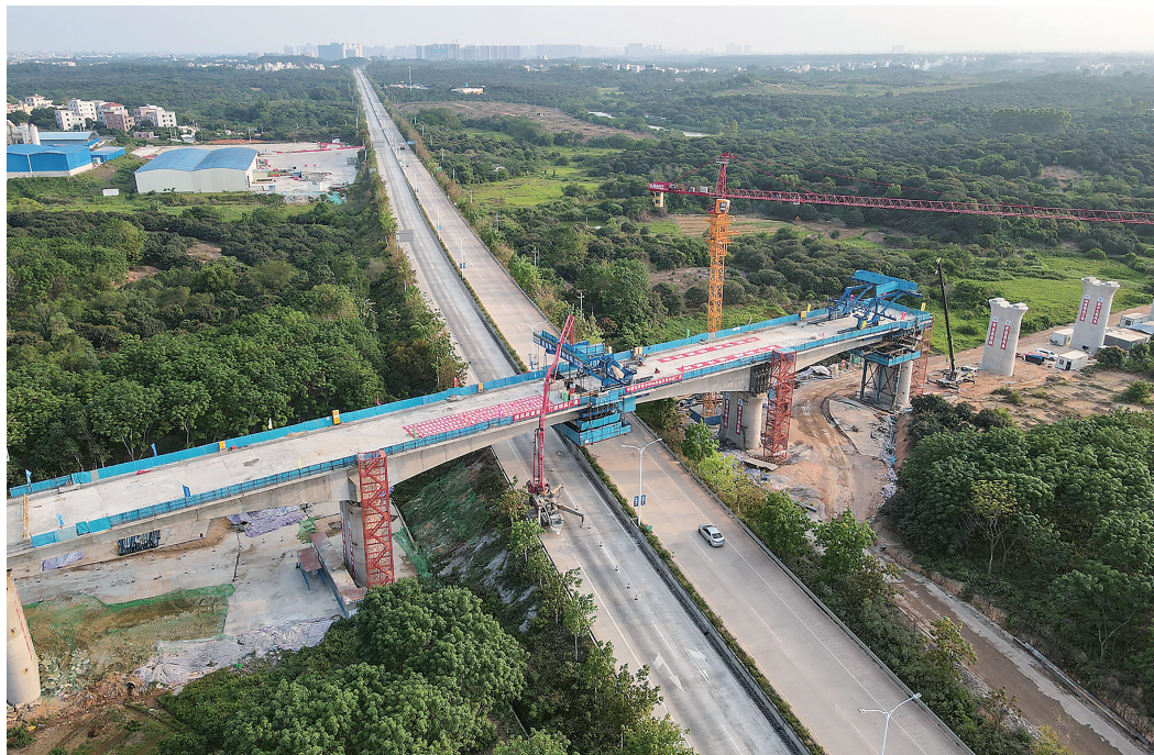
广湛高铁全线首座连续梁顺利合龙。 茂名日报社全媒体记者 岑稳 摄
