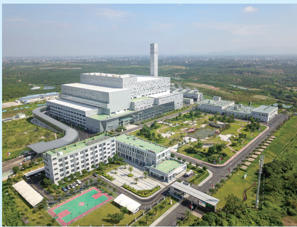
茂名粤丰环保电力有限公司厂区全景图
