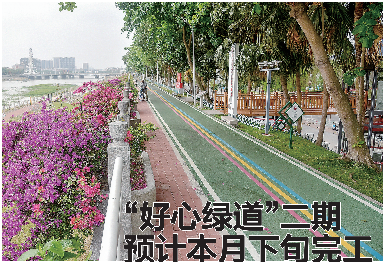
◀绿道二期小东江河堤路段
