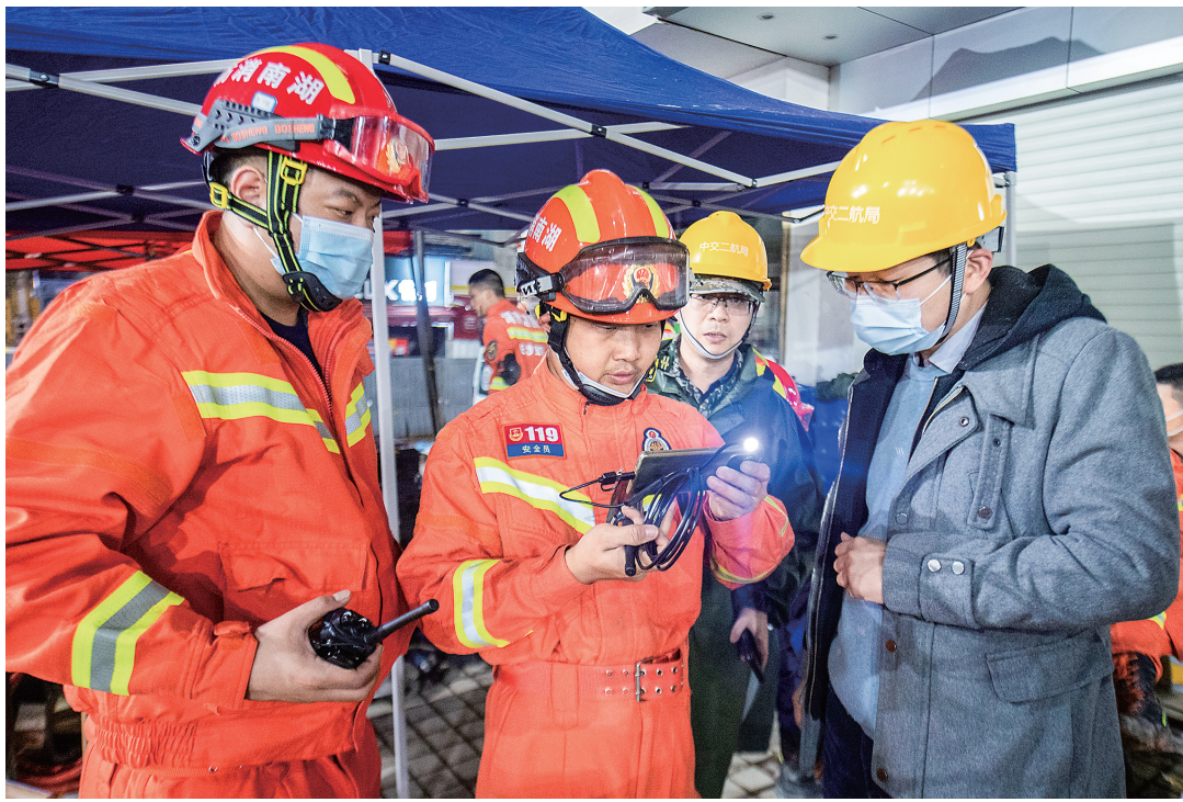
5月1日凌晨,救援人员在湖南长沙居民自建房倒塌事故现场进行救援。 新华社记者 陈思汗 摄
