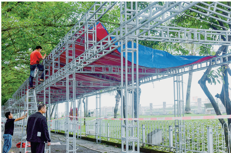
近日,市区江东中路特色水果街建设工程动工,施工人员在搭建摊位棚架。据了解,该工程预计5月底前完工并投入使用。
