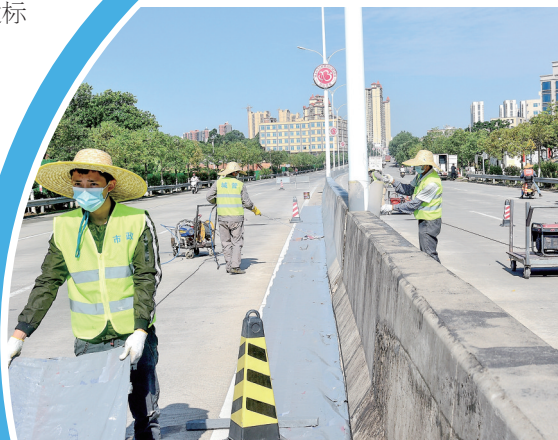
昨日,记者在茂东快线石曹村路段看到,市政工人正在对道路中间隔离护栏进行喷漆维护施工,营造安全、优美的道路交通环境。 茂名日报社全媒体记者陈国汉 摄
