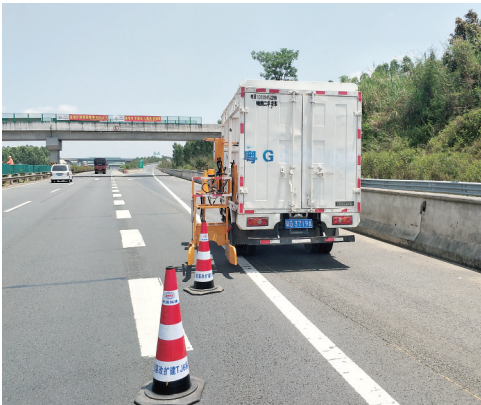
路锥自动收放车在茂湛高速改扩建TJ6标涉路施工现场作业。
