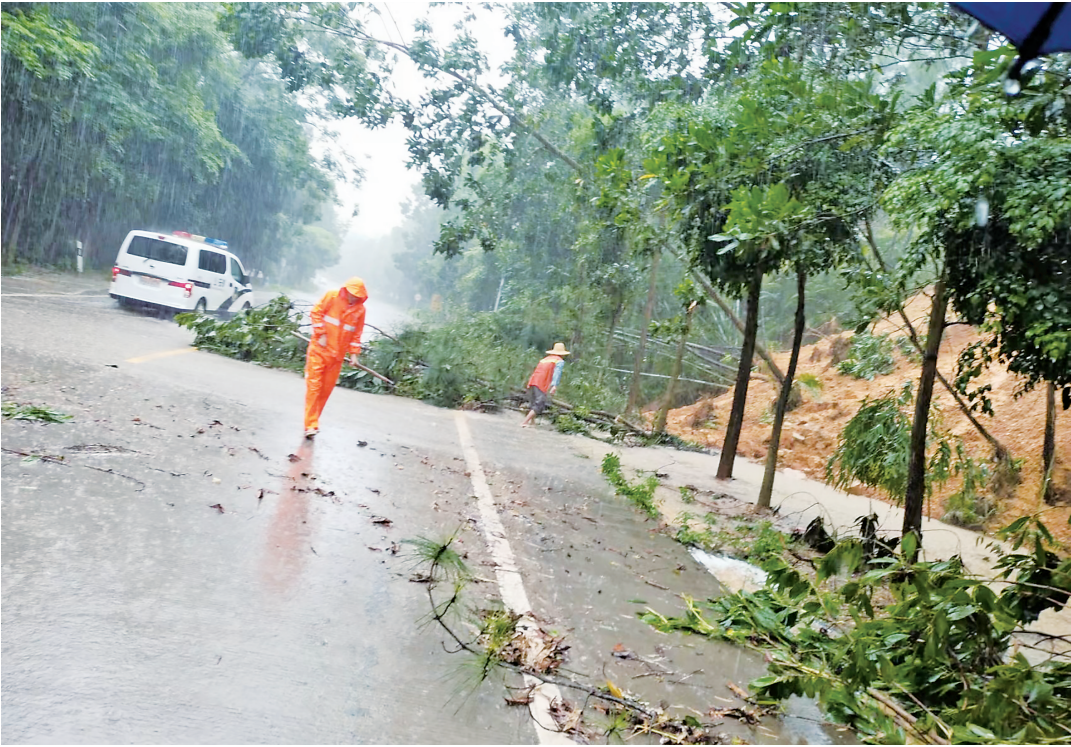
工人在现场清理淤泥和倒伏的大树。
