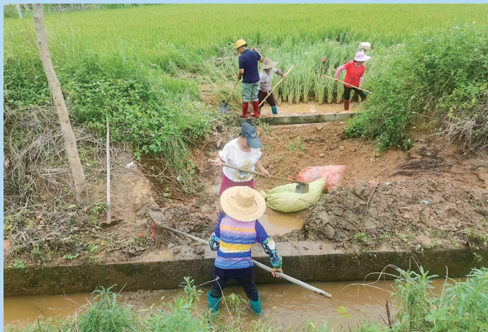
▲工作人员对塌方进行修复。
