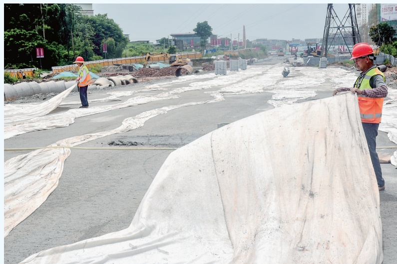
昨日,在市区双山八路施工现场,施工人员进行路面水稳层养护施工。据了解,目前路面大部分已完成水稳层铺设,即将进行铺设沥青。
