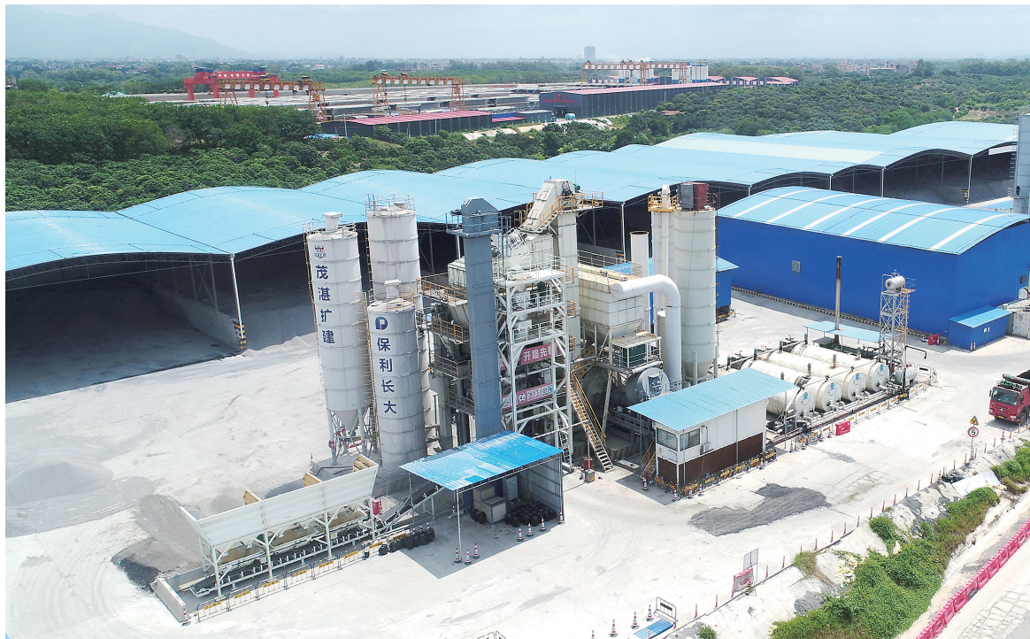
茂湛扩建TJ1标拌合站拌合楼。
