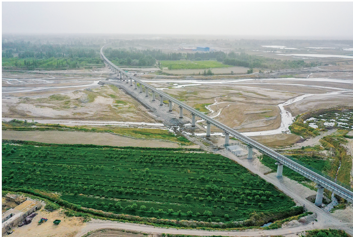
这是5月18日拍摄的和若铁路车尔臣河特大桥（无人机照片）。新华社记者 丁磊 摄
