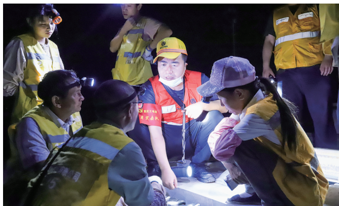
重庆工电段现场技术负责人吴军正在给作业人员进行技术交底,叮嘱安全注意事项。(中国铁路成都局集团有限公司重庆工电段供图)
