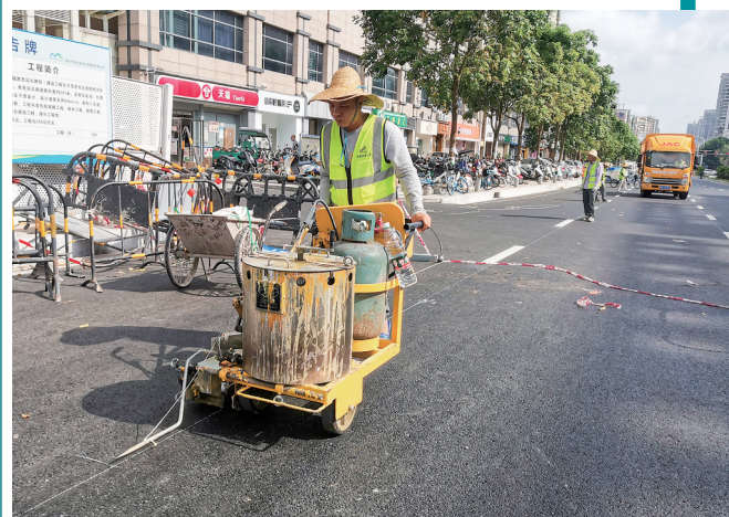
施工人员进行道路标线施工。
