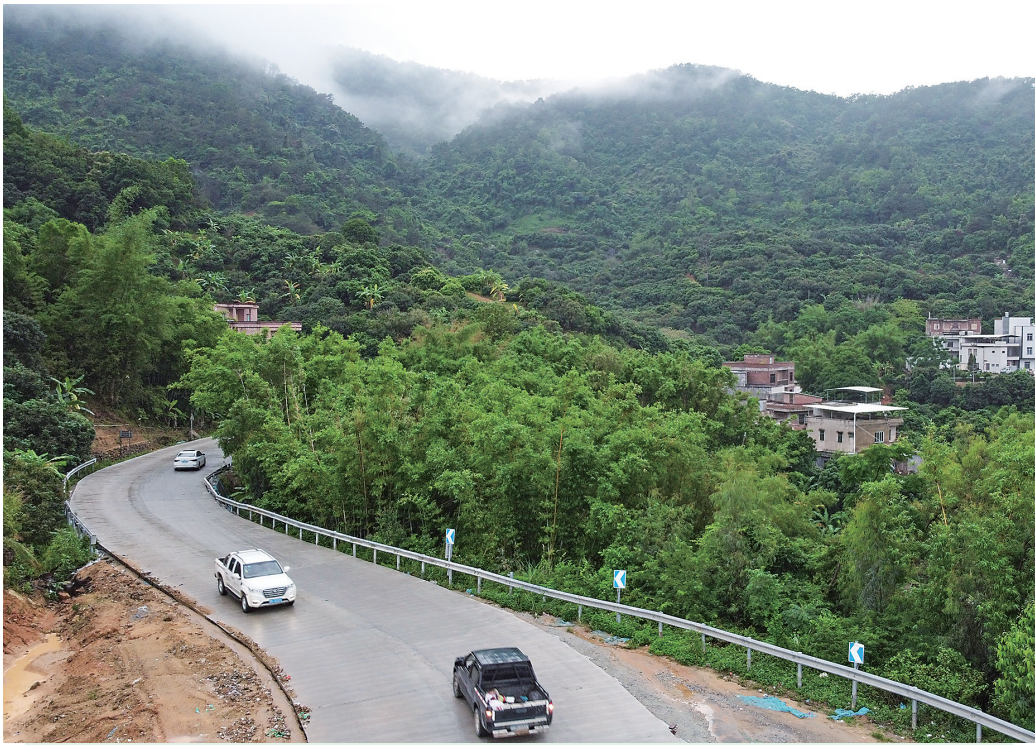
高州长坡至大坡公路双向通车。茂名日报社全媒体记者黎雄 摄
