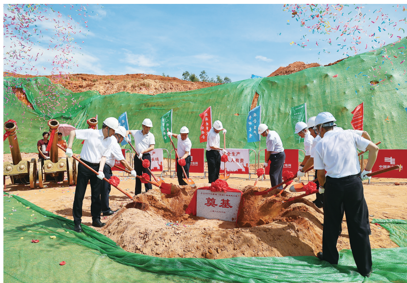
在水东湾新城管委会、南方电网广东茂名供电局以及施工单位的见证下,茂名220kV晏镜(茂港)输变电工程开工建设。 叶泽 摄
