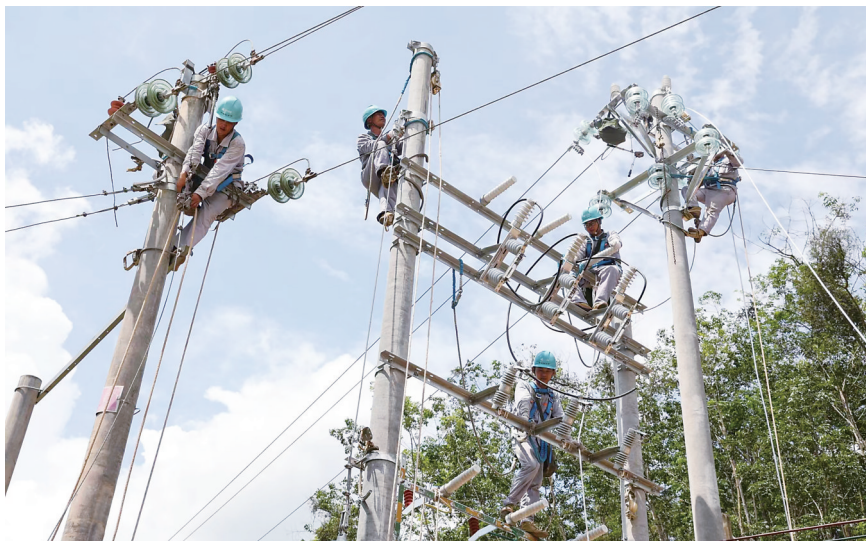
电力施工人员顶着骄阳烈日,争分夺秒进行电力设备安装工作。
