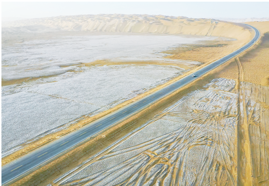
6月26日拍摄的尉犁至且末沙漠公路,工作车辆在路面行驶(无人机照片)。新华社记者 李响 摄
