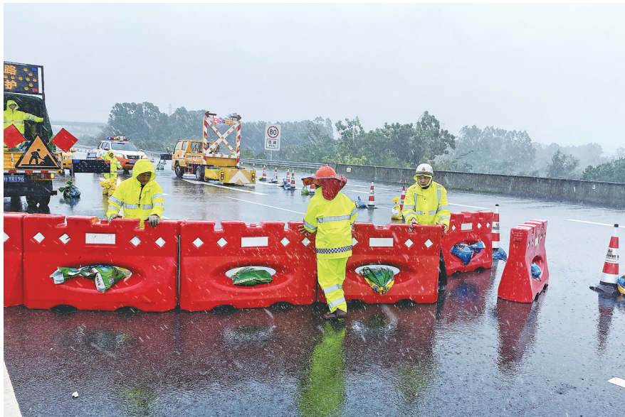
茂湛高速路政、交警、养护人员紧急部署道路紧急封闭措施。
