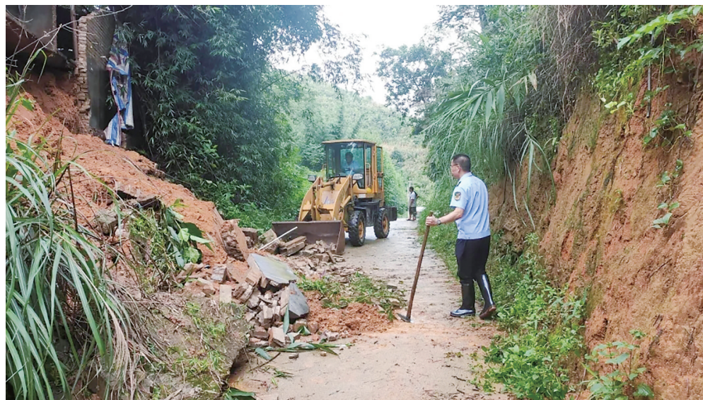
朱砂镇出动挖掘机进行清淤。 茂名晚报 通讯员 苏冠源 摄
