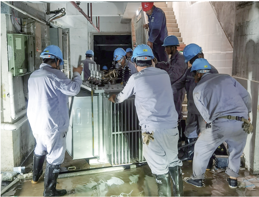
7月9日,施工人员正在更换受水浸的变压器。通讯员庞世俊 摄
