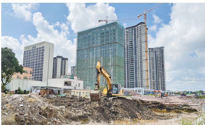
昨日,在市区天桥路南段项目施工现场,施工人员顶着烈日填筑塘尾村路段路基,争取工程早日完工。 茂名日报社全媒体记者李颜东 摄
