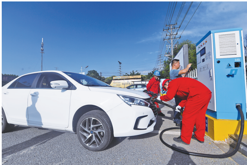
6月7日,工作人员来到浙江长兴县“家之窗电动汽车充电站”,对充电桩进行安全检查,并指导新手车主进行扫码充电。该电动汽车充电站具有直流快充桩15台,可供30辆电动车同时充电。新华社记者 徐显摄
