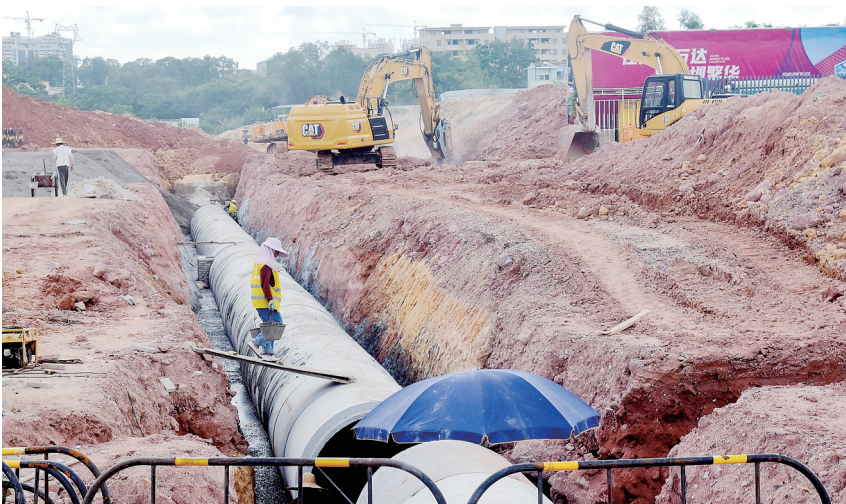
昨日,记者在市区东粤路与双山八路交汇处路段看到,施工人员正在加紧进行地下排水管道铺设施工,稳步有序推进东粤路项目建设。 茂名日报社全媒体记者 陈国汉 摄
