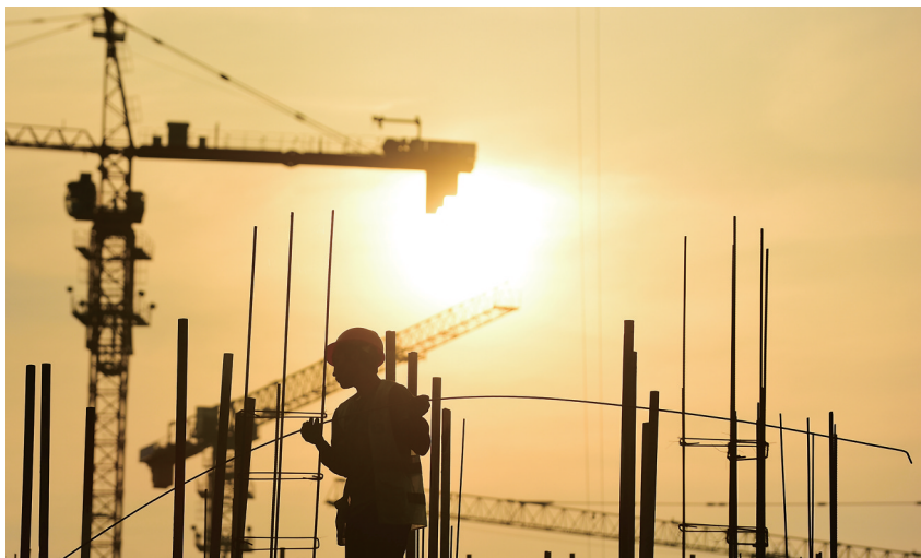
7月12日,工人在江苏无锡经开区的一处住宅小区建设工地上施工。
