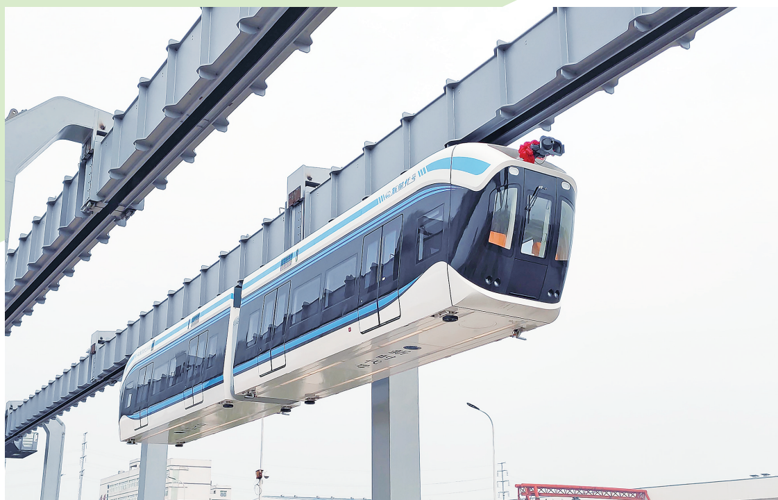
▲中国中铁工业自主研发的新时代号“空轨”试验线。
