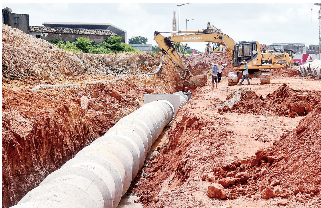
昨日,在市区双山八路项目建设施工现场,施工人员正在冒着酷暑、顶着烈日铺设地下排水管道,争取双山八路早日建成通车。 茂名日报社全媒体记者 陈国汉 摄
