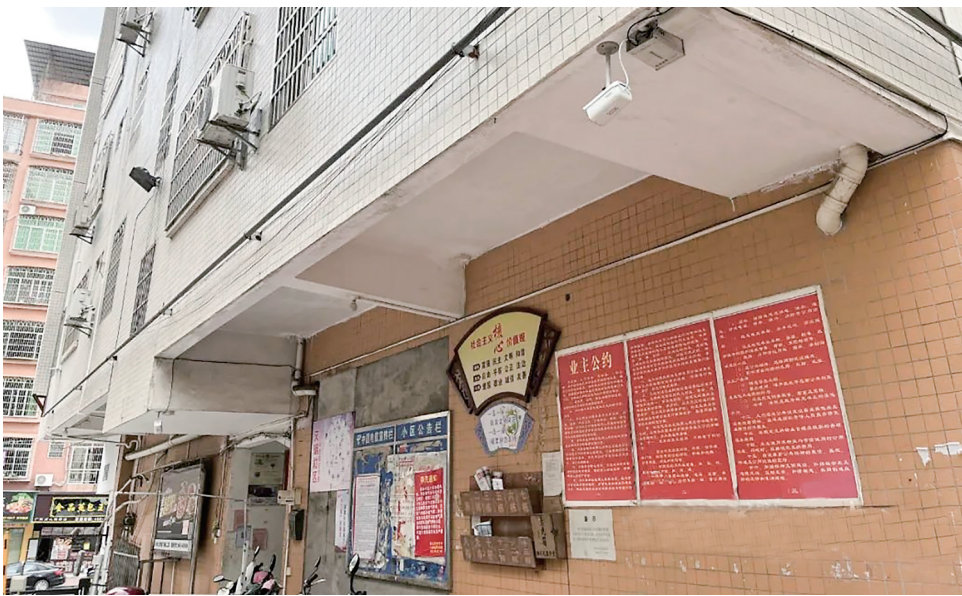
高州文明社区御名苑小区居民楼下安装了高清监控摄像头。
