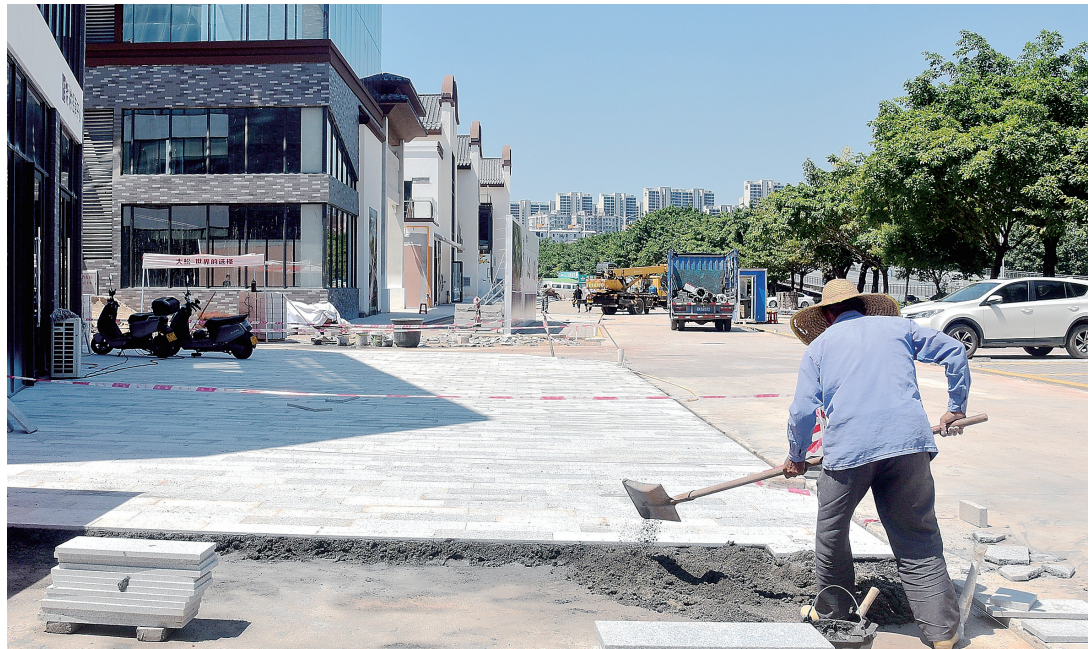
昨日,记者在市区光华南路乾村建设施工现场看到,施工人员正冒着酷暑、顶着烈日铺设地板砖。据了解,乾村建设工程已进入收尾阶段。
