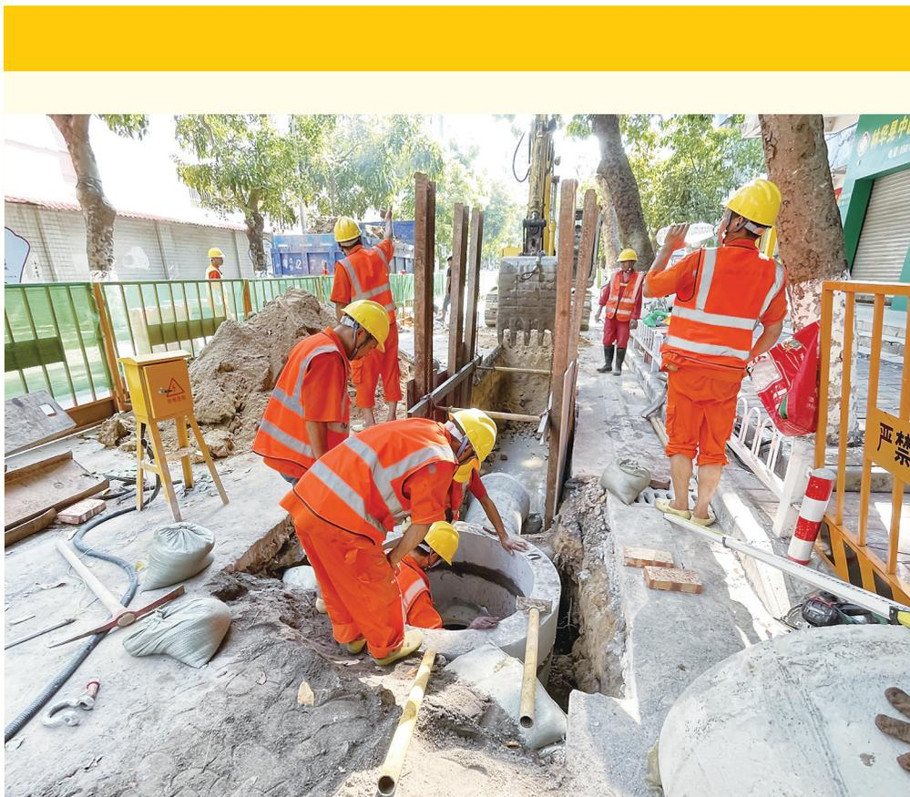
昨日,记者在市区口岸街污水管网改造施工现场看到,施工人员顶着烈日铺设污水管,加紧施工进度,预计该路段污水管铺设工程可在月底完工。
