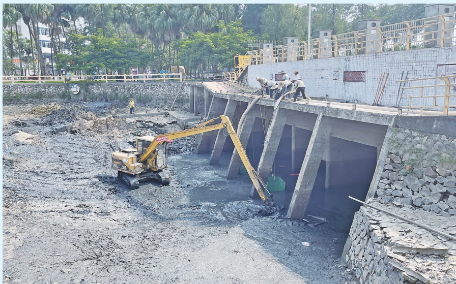
昨日,在市区的滨河北路,施工人员顶着烈日抢修一号湖泵站闸口栅栏,确保汛期泵站安全排洪,预计抢修工作可在今日完成。
