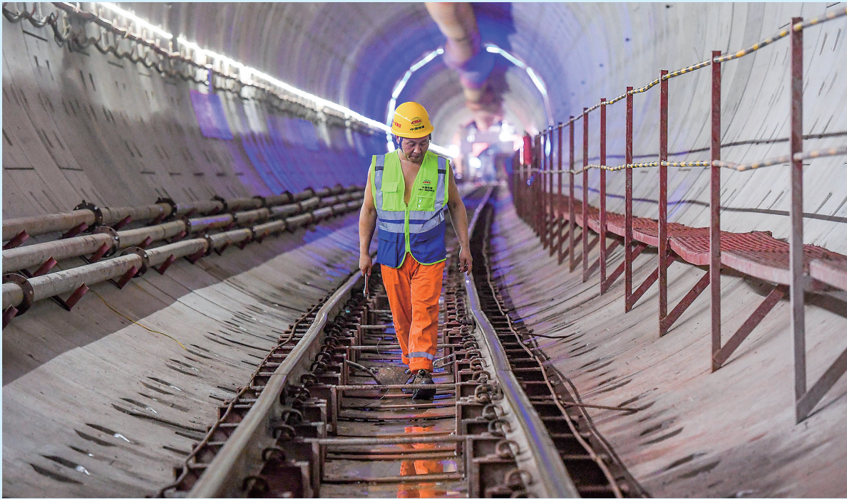
8月2日,建设者在广州地铁十号线东湖站至滨江东路站区间巡查盾构水平运输轨道。 当日,中铁十一局施工的广州地铁十号线东湖站至滨江东路站区间盾构机双线安全下穿珠江航道。该区间隧道全长1260余米,下穿珠江航道600米。广州地铁十号线线路呈东北—西南走向,与多条线路形成换乘。 新华社记者 刘大伟 摄
