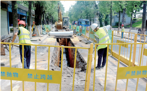
8月2日,在市区滨河北路污水管网建设施工现场,施工人员正在加紧进行污水管网铺设施工。据施工方介绍,该工程预计本月10日前完工。
