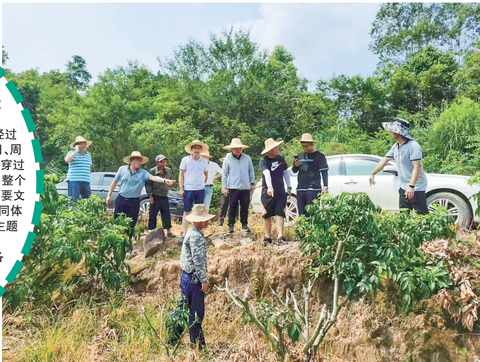
临时党总支主要成员深入施工一线解决项目建设问题。
