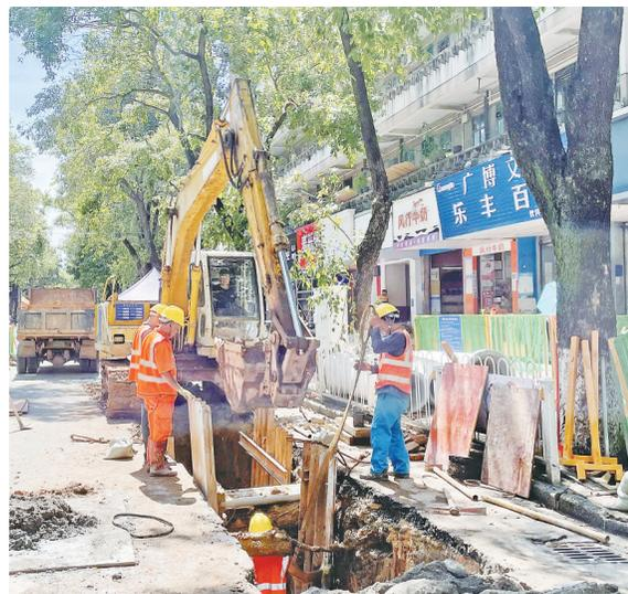
昨日,在市区为民路污水管网完善工程施工现场,施工人员正加紧铺设污水管,争取工程早日完工。
