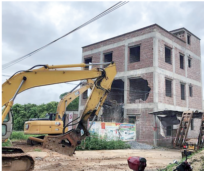
依法拆除违法建筑。
