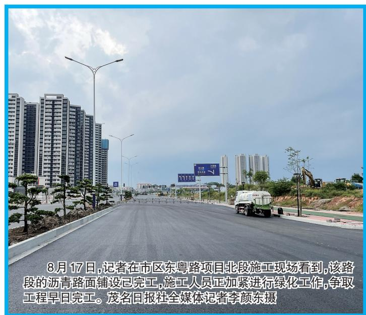
8月17日,记者在市区东粤路项目北段施工现场看到,该路段的沥青路面铺设已完工,施工人员正加紧进行绿化工作,争取工程早日完工。茂名日报社全媒体记者李颜东摄
