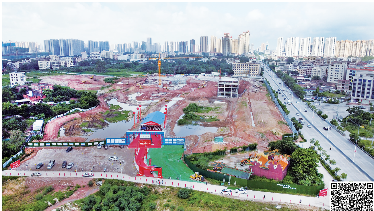
▲城投·梓悦台项目施工工地。茂名日报社全媒体记者黄信涛摄
