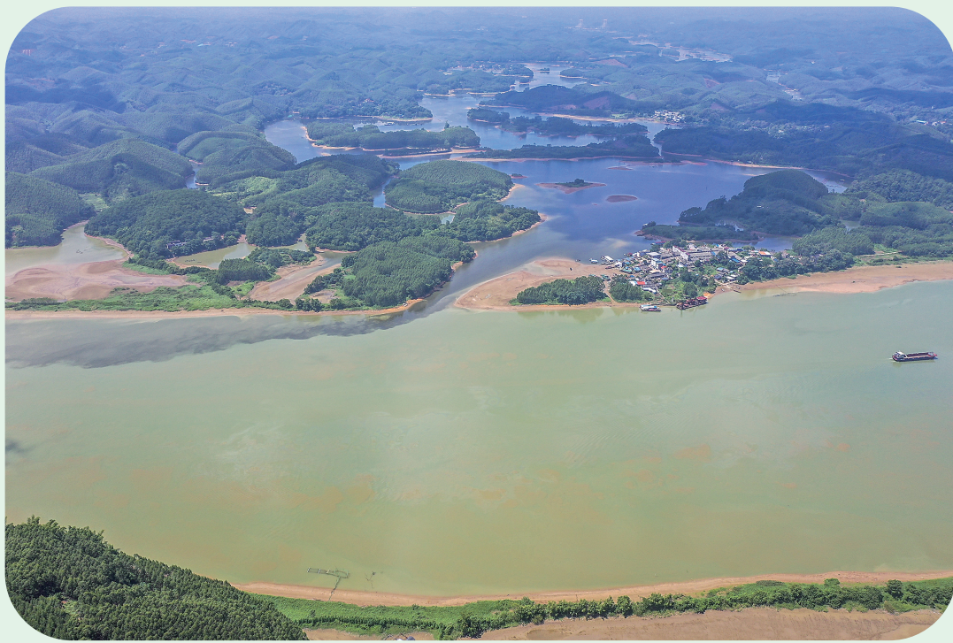
这是8月27日拍摄的平陆运河茅尾海龙门大桥段(无人机全景照片)。新华社记者 曹祎铭摄
