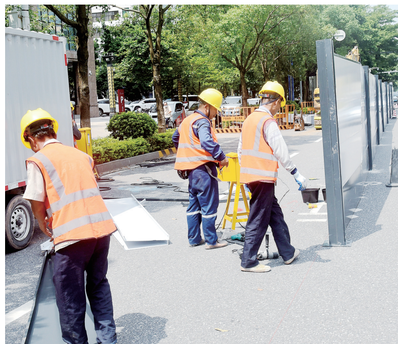
8月29日,市区油城七路污水管网建设工程开始动工,施工人员正在围蔽施工现场。据施工方介绍,该工程预计9月10日前完工。 茂名日报社全媒体记者 陈国汉 摄
