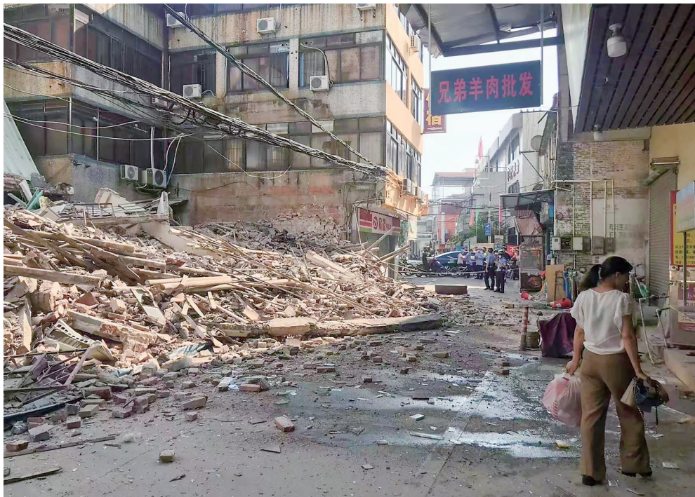
坍塌后的房屋。(受访者供图)
