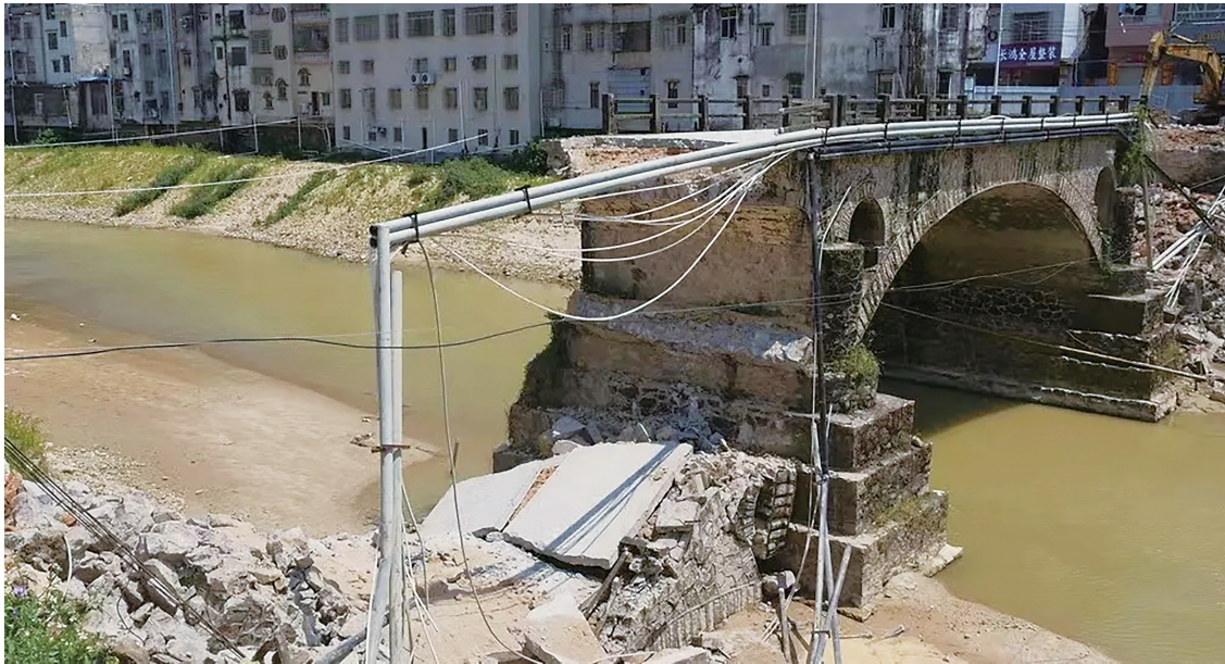
北界桥开始拆除。茂名晚报通讯员陆波 摄
