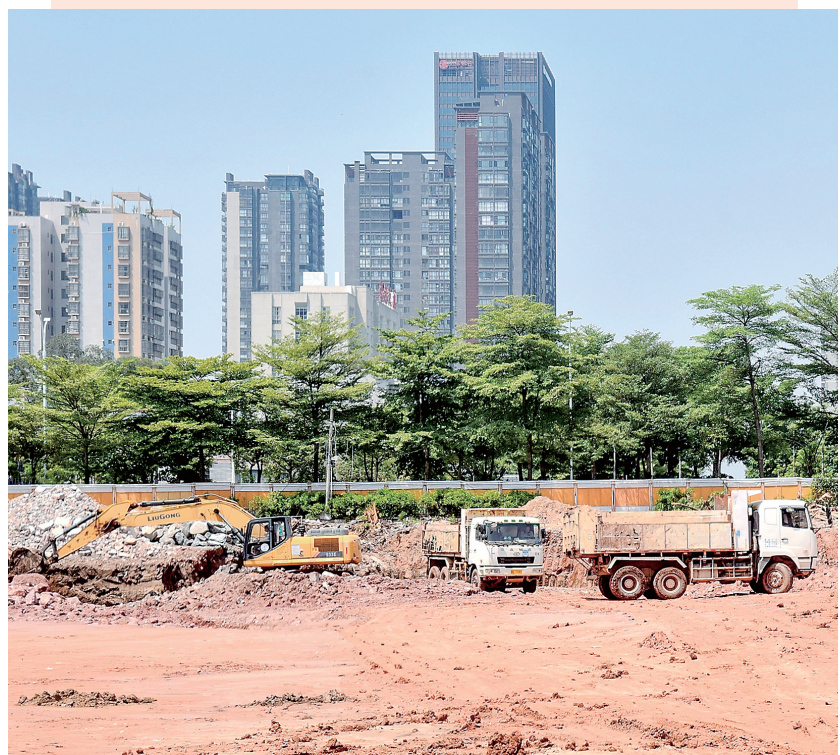
昨日,在市区双山八路与茂名大道交汇处路段,施工人员正在进行路基土方开挖施工。据施工方介绍,双山八路预计11月30日完成半路面通车。 茂名日报社全媒体记者 陈国汉 摄
