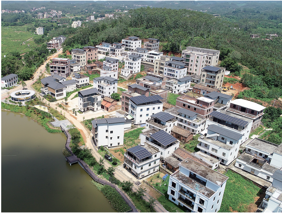
推进屋顶光伏。 通讯员 周航 摄
