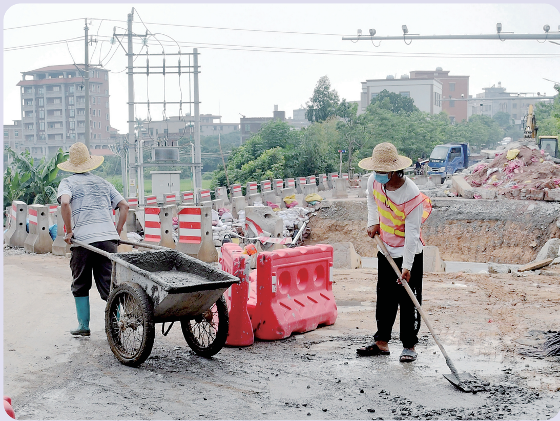
昨日,记者在县道X634线羊角段改造工程施工现场看到,施工人员正在围蔽路段加紧施工。该工程完成后,群众出行将更便捷顺畅。 茂名日报社全媒体记者 陈国汉 摄
