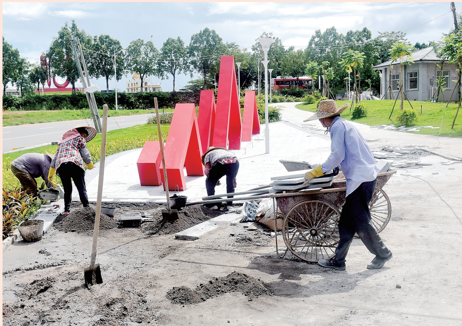
昨日,在市区站北七路社区体育公园施工现场,施工人员放弃国庆假日休息,坚守岗位,加紧铺设公园地板砖,争取早日建成开放。 茂名日报社全媒体记者 陈国汉 摄
