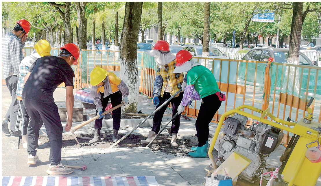
昨日,市区文化广场雨污分流改造工程正式动工,施工人员正在进行排水管道沟槽开挖施工。据施工方介绍,该工程预计工期为30天。
